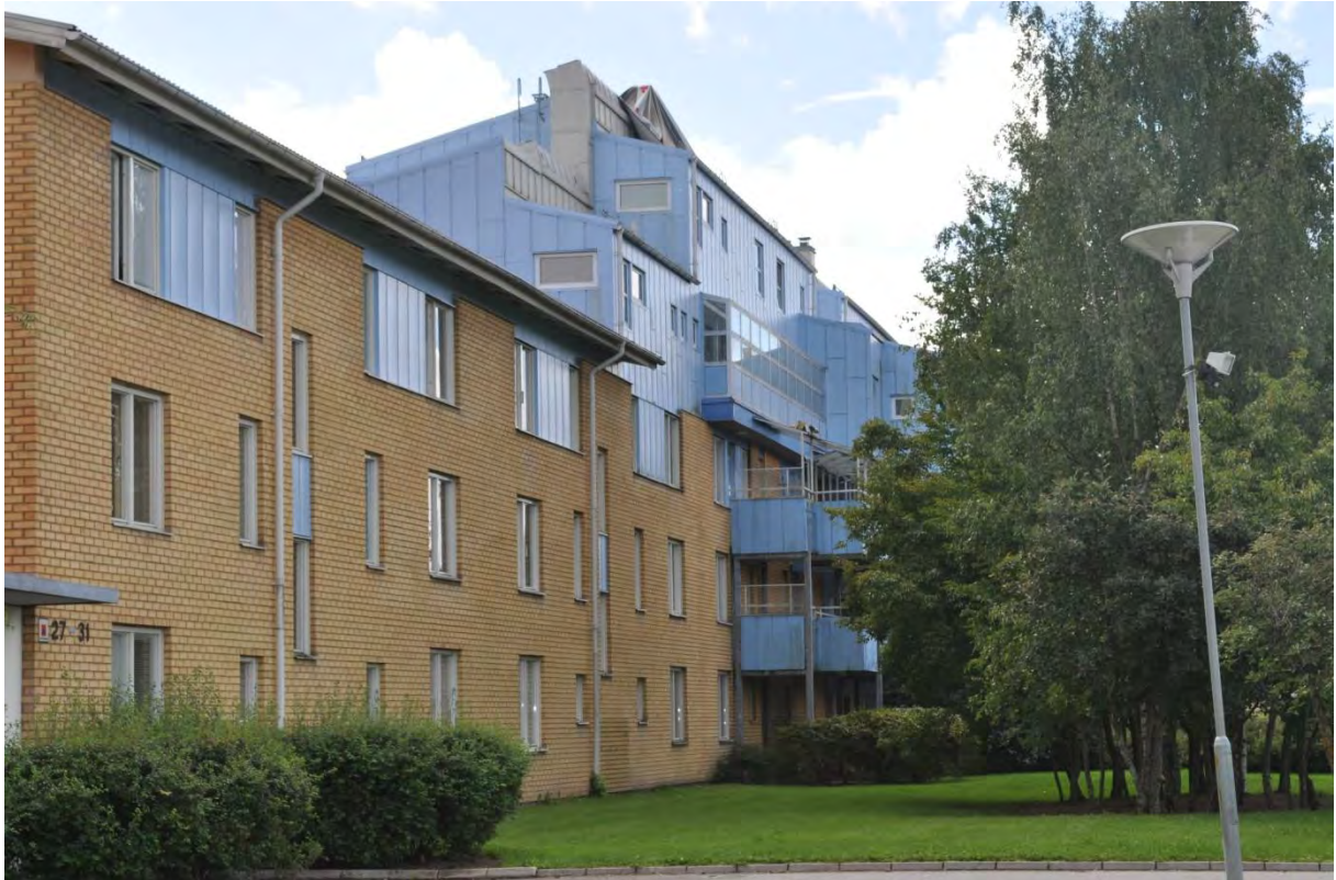
Den branddrabbade byggnaden, vy från öster.
