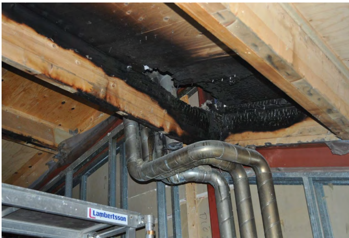
Brandskadad balk och skador i yttertak.
