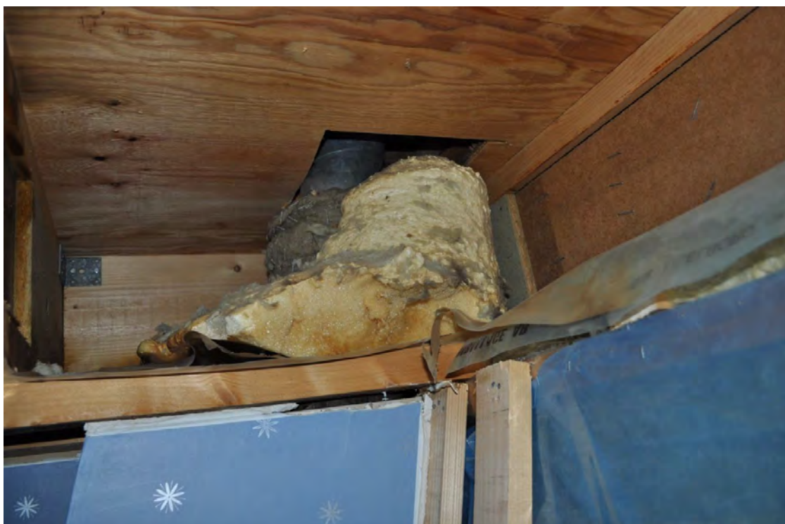
Kanalgenomföring genom inner- respektive yttertak. Fotot, som är taget i det nordöstra sovrummet, visar en frilagd del av schaktet kring imkanal från en angränsande lägenhet.
