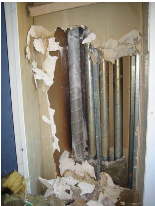
Frilagt schakt i sovrum, plan 4. På bilden syns imkanalen till vänster och frånluftskanalerna till höger samt den gemensamma brandisoleringsmattan mot bjälklagsgenomföringen.
