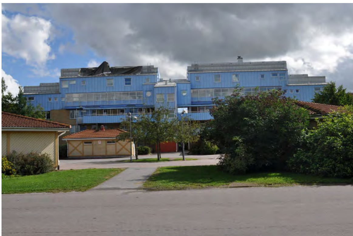
Den branddrabbade byggnaden, vy från norr.
